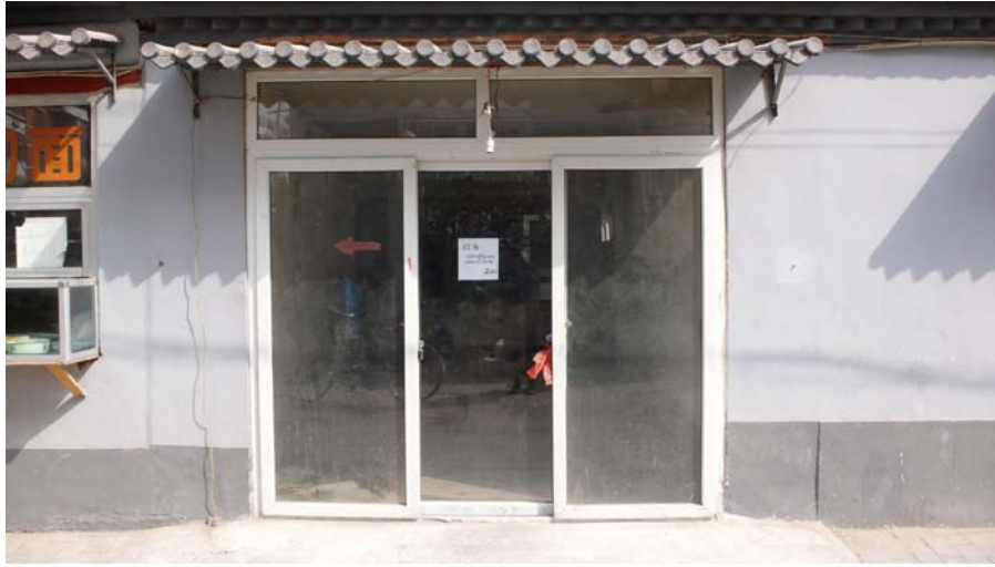
图片 Image 7: 空间外部正面 Arrow Factory facade
