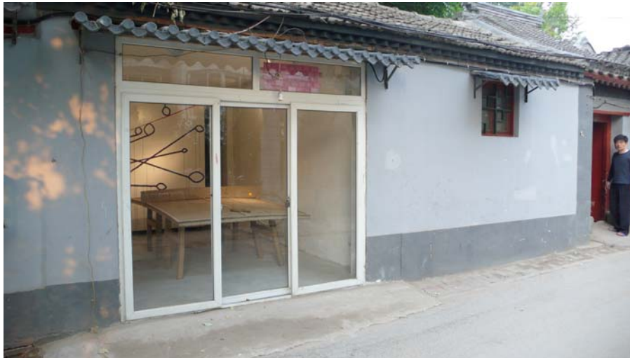
图片 Image 8: 空间外部正面 Arrow Factory facade
